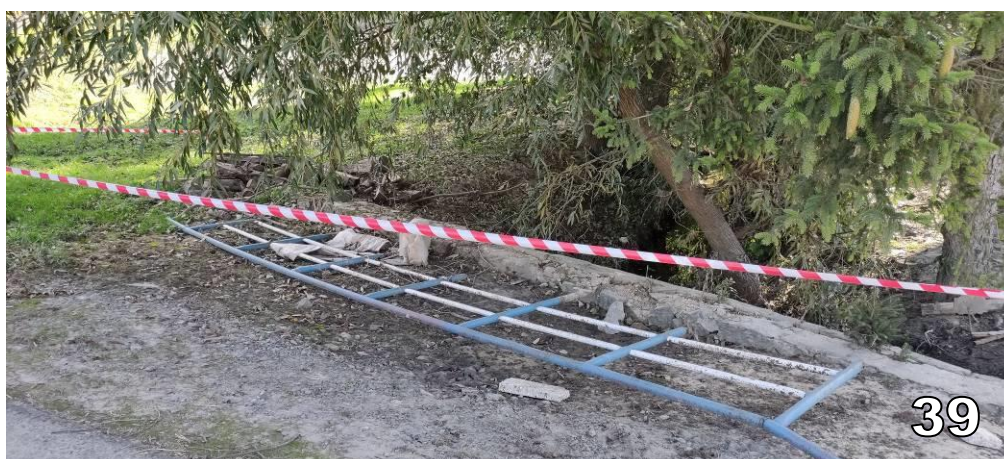
Rudziczka mosty, kładki, przepusty (zdj. 39-41)
